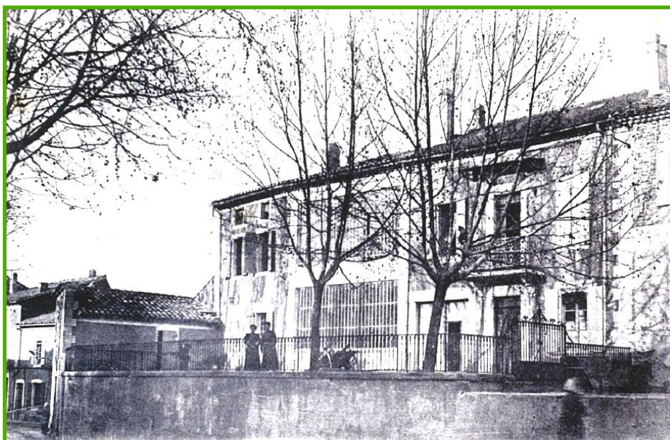
Station électrique et moulinage
